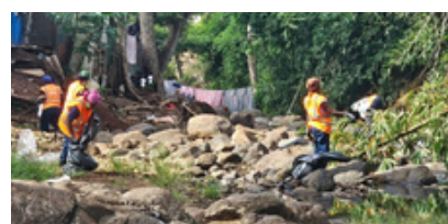
Juin Début des chantiers de restauration RESTOCOR
